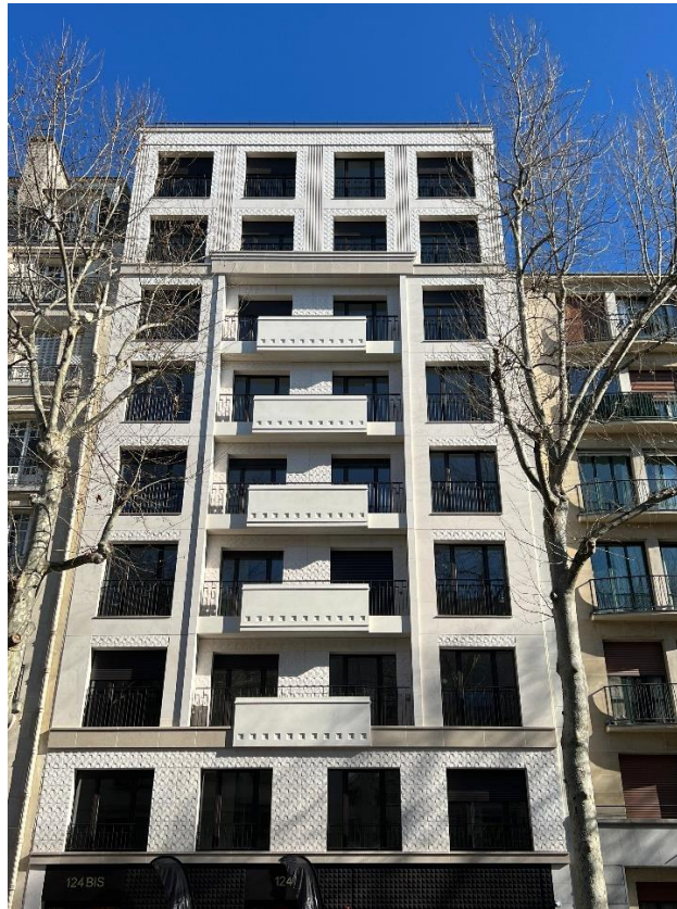
Façade de « La Galerie Peretti » à Neuilly-Sur-Seine
