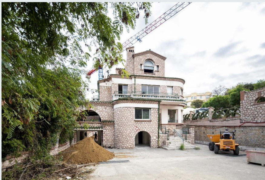
Chantier en cours ©Julien Cresp
