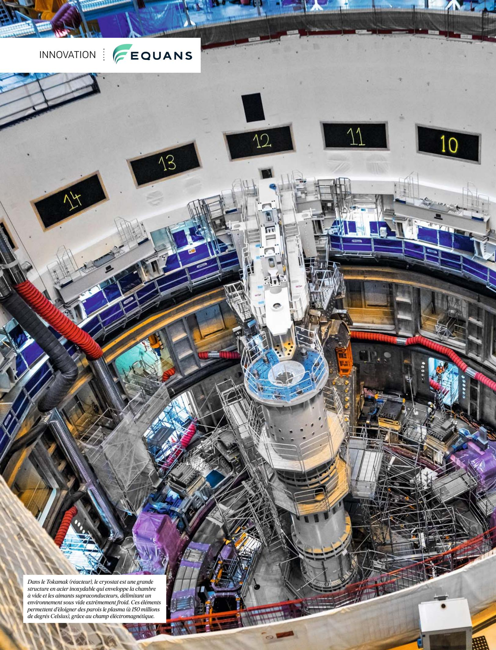
*Dans le Tokamak (réacteur), le cryostat est une grande structure en acier inoxydable qui enveloppe la chambre à vide et les aimants supraconducteurs, délimitant un environnement sous vide extrêmement froid. Ces éléments permettent d'éloigner des parois le plasma (à 150 millions de degrés Celsius), grâce au champ électromagnétique.*
