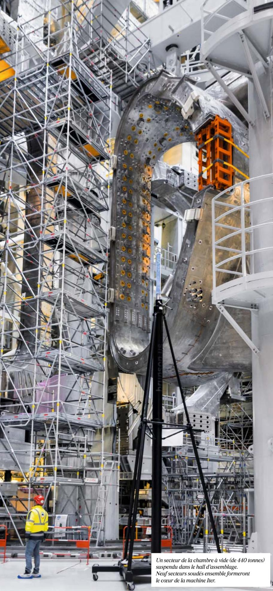
*Un secteur de la chambre à vide (de 440 tonnes) suspendu dans le hall d'assemblage. Neuf secteurs soudés ensemble formeront le cœur de la machine ITER.*
