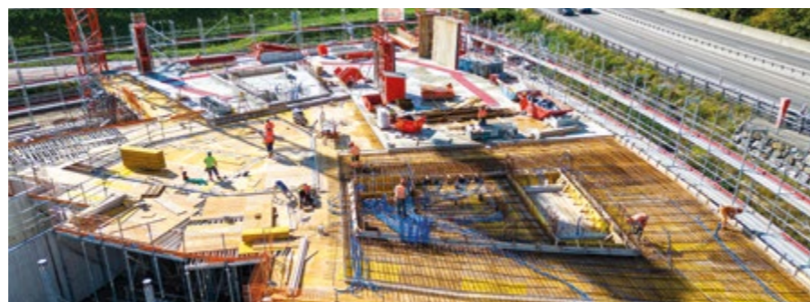
+ SCHWEIZ – An der Stauffacherstrasse 131 in Bern hat Losinger Marazzi (Bouygues Construction) ein Dienstleistungsgebäude in Holzhybridbauweise errichtet.
