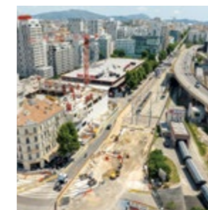
Verlängerung der Strassenbahnlinie T3 in Marseille (Colas)
