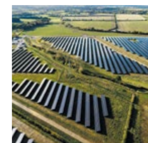
Equans Solar and Storage, Solarpark im Vereinigten Königreich
