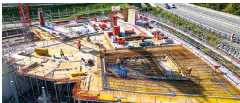
+ SUISSE - Au 131 de la Stauffacherstrasse à Berne, Losinger Marazzi (Bouygues Construction) a développé et réalise un bâtiment de services en structure bois hybride.
