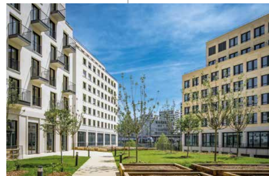
FRANCE - Au cœur du quartier Lyon Confluence, Sollys est un projet mixte qui comprend à la fois des bureaux, des logements et des commerces.
