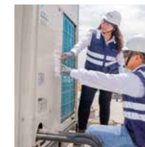
Data center Equans au Pérou
