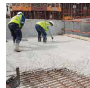
Béton bas carbone chez Bouygues Construction
