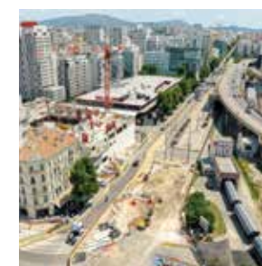
Prolongement de la ligne de tramway T3 à Marseille (Colas)
