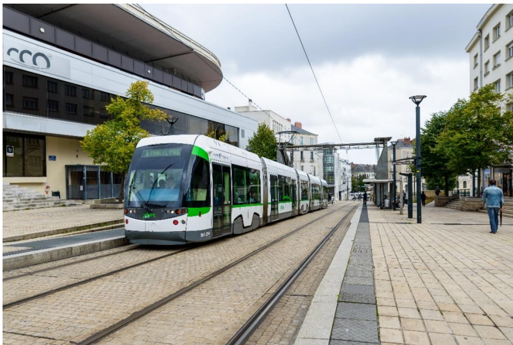
Photo du chantier du tramway de Nantes qui a inspiré la création du Colas Carbon Counter. Crédit : Colas
