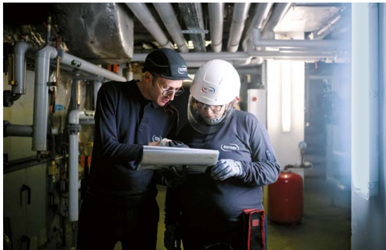
FRANKRIJK – Electra is de eerste opleiding die zich uitsluitend richt tot vrouwen die zich omscholen tot elektriciens, een initiatief van Bouygues Energies & Services. Hier, Morgane Prime, naast haar mentor, Idir Sidhoum.
