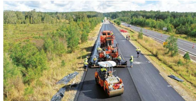
【オーストラリア】ニューサウスウェールズ州クライバッカルトにSMA10級のアスファルトを敷設するコラス・オーストラリア (Colas Australia) の作業員たち
