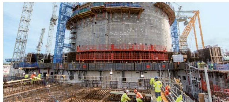
REINO UNIDO - Bouygues Travaux Publics, en el marco del consorcio Bylor, se encarga de las obras de ingeniería civil de los dos reactores EPR de la futura central nuclear de Hinkley Point.
