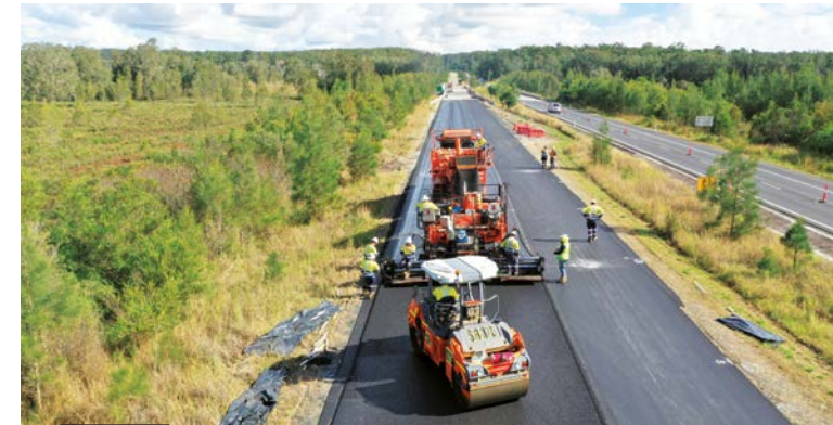
AUSTRALIA - Un equipo de Colas Australia aplicando asfalto tipo SMA10 en una carretera de Clybucca, Nueva Gales del Sur.
