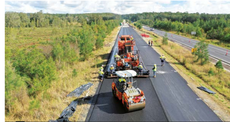
호주 - 콜라스 호주팀이 호주 뉴사우스웨일즈 클라이부카의 도로에 SMA10급 아스팔트를 설치하고 있다.
