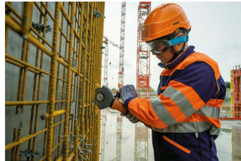
국제부문 - 파인과의 파트너십을 통해 3년간 연구개발 결과 탄생한 안전 그라인더를 프랑스와 국제부문 현장에서 사용중이다.
