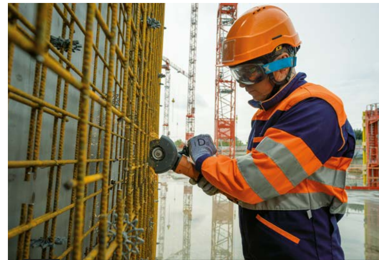
MONDE - 具有极高安全性的研磨机是我们与工具公司 Fein 合作研发三年的成果，使用于本集团海内外的公司。
