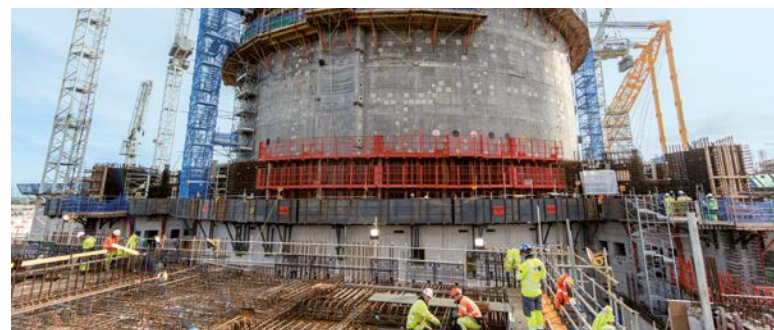
VEREINIGTES KÖNIGREICH - Bouygues Travaux Publics baut als Teil des Bylor-Konsortiums die strukturellen Elemente der beiden EPR-Reaktoren für das künftige Kernkraftwerk Hinkley Point.
