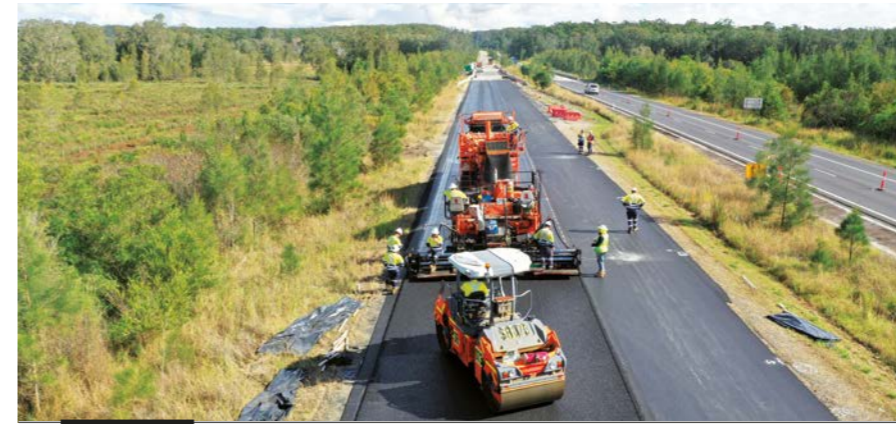
AUSTRALIEN – Ein Team von Colas Australia bringt Asphalt mit der Klassifizierung SMA10 auf einer Strasse in Clybucca, New South Wales, auf.
