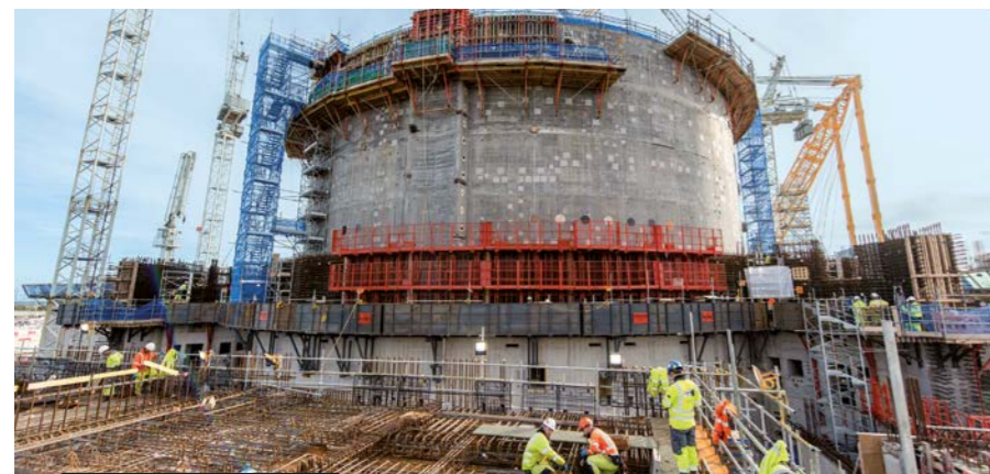
VEREINIGTES KÖNIGREICH – Bouygues Travaux Publics baut als Teil des Bylor-Konsortiums die strukturellen Elemente der beiden EPR-Reaktoren für das künftige Kernkraftwerk Hinkley Point.
