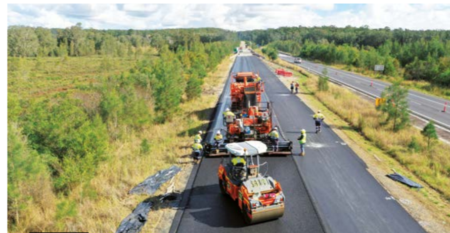
AUSTRALIE - Une équipe de Colas Australia applique de l'asphalte classé SMA10 sur une route de Clybucca, en Nouvelle-Galles du Sud.
