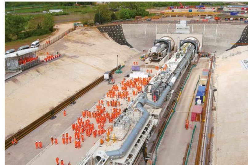
Verbeterde mobiliteit dankzij de hogesnelheidslijn HS2, het grootste transportinfrastructuurproject in het VK. HS2 biedt een directe verbinding tussen Londen en Birmingham en buigt vervolgens af naar Manchester. Het traject dat momenteel wordt aangelegd (21,6 km) ten noordwesten van de Britse hoofdstad, omvat een viaduct en twee tunnels.
