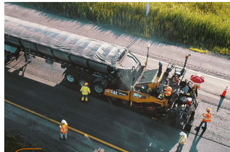
De circulaire economie aan het werk bij de herstellingswerken aan de Interstate 81, die door North Syracuse loopt (in de staat New York). Dankzij de gebruikte techniek kan het freesmateriaal meteen in het nieuwe wegdek worden hergebruikt. Nog een voordeel is dat 35 000 ton freesmateriaal op andere werven in de regio kan worden hergebruikt. Het door de klant verwachte recyclingpercentage is overtroffen.
