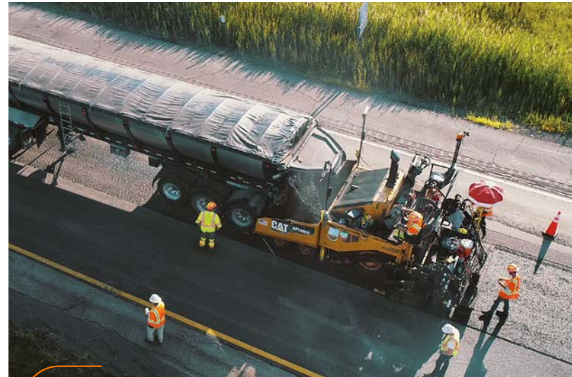
노스 시러큐스(뉴욕주)를 관통하는 인터스테이트 81 도로 보수 공사 현장의 순환경제. 평삭한 소재를 즉시 코팅재 생산에 다시 사용할 수 있는 기술을 사용하고 있다. 또한 밀링된 소재 35,000톤을 지역의 다른 현장에서 사용하는 장점도 있다. 이는 고객이 요구하는 재활용 목표치를 뛰어넘는 실적이다.
