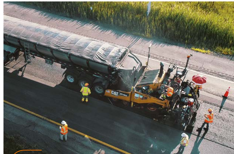
ニューヨーク州の村ノース・シラキユースを通過する州間高速道路81号線の修復工事。「循環型経済」のコンセプトによるこの工事では、削り取った材料を新たな道路舗装材として直ぐに再利用できる技術が使われている。また、3万5000トンの粒状材料が地域の他の現場でも再利用されている。この結果、ここでは顧客の期待以上のリサイクル率を実現している。
