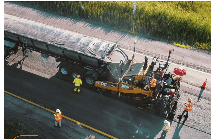
Economía circular en las obras de rehabilitación de la carretera interestatal 81 en North Syracuse (Estado de Nueva York). La técnica utilizada permitió reutilizar inmediatamente el material recuperado en el nuevo aglomerado asfáltico. Otra ventaja: 35.000 toneladas de material fresado se reutilizaron en otras obras de la región superando el porcentaje de reciclaje esperado por el cliente.
