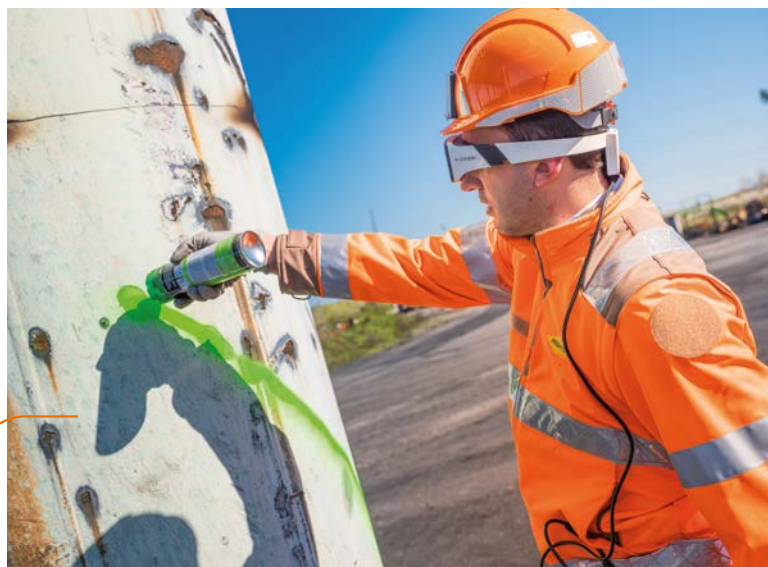
Desmantelamiento de una planta en Ambès, en el sudoeste de Francia. Gracias al casco de realidad aumentada, el empleado puede ver en tiempo real las delicadas tareas que debe realizar, lo que elimina el riesgo de error al interpretar el plano de la obra y refuerza su seguridad.
