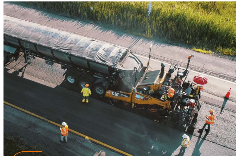
穿越北Syracuse镇（纽约州）的81号州际公路修案运用了循环经济。这项工程施工使用的技术让新铺的沥青可立即重复使用原来路面铣刨下来的材料。另一个好处：35,000公吨旧料被回收利用到该地区其他工地的施工之中。这件工程案的旧料回收率超出客户预期。
