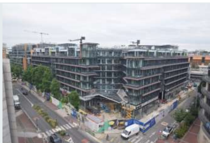
Fin des travaux de réhabilitation – novembre 2021.
