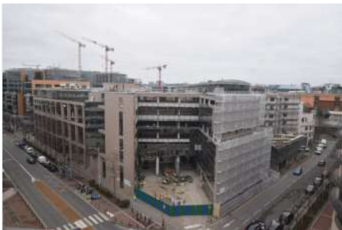
Début des travaux de l'immeuble SWAYS – été 2018.
