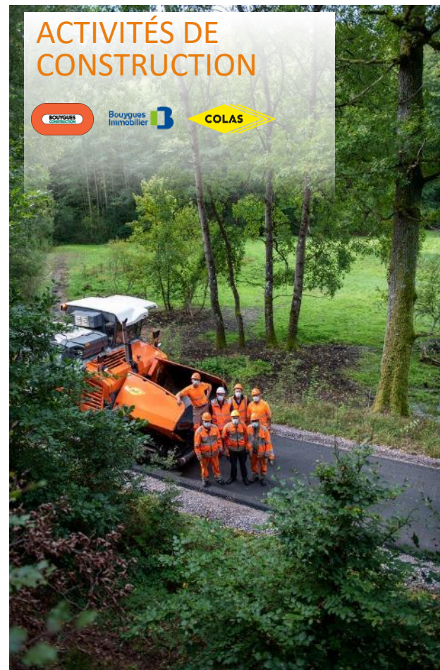
Construction de pistes cyclables – Alsace – France
