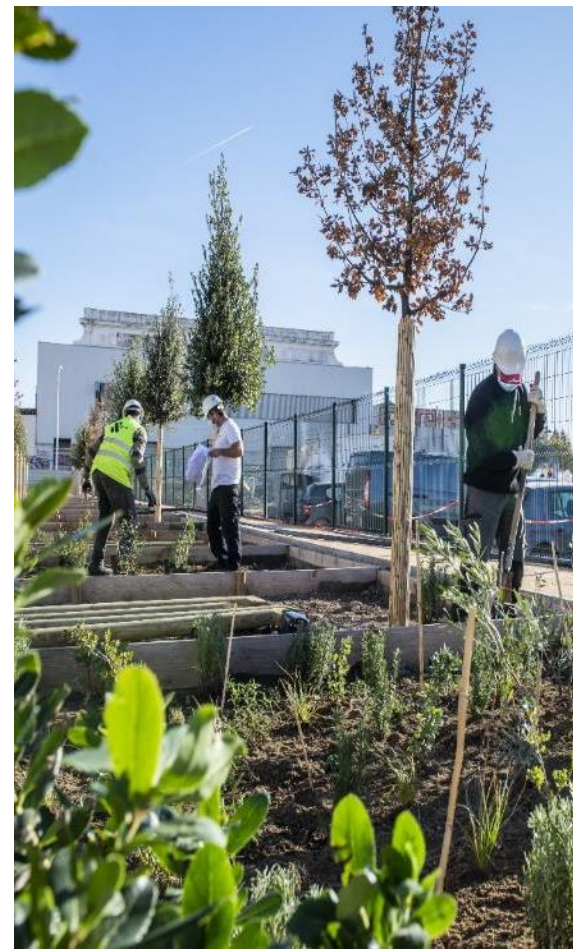
Réhabilitation des Fabriques de Marseille - France
