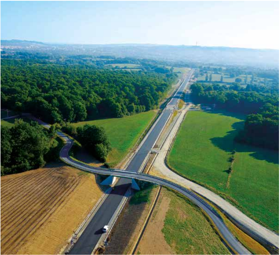
La variante suroeste de Vichy (PPP), entregada en enero de 2016, incluye un tramo de carretera de 18,6 kilómetros.
