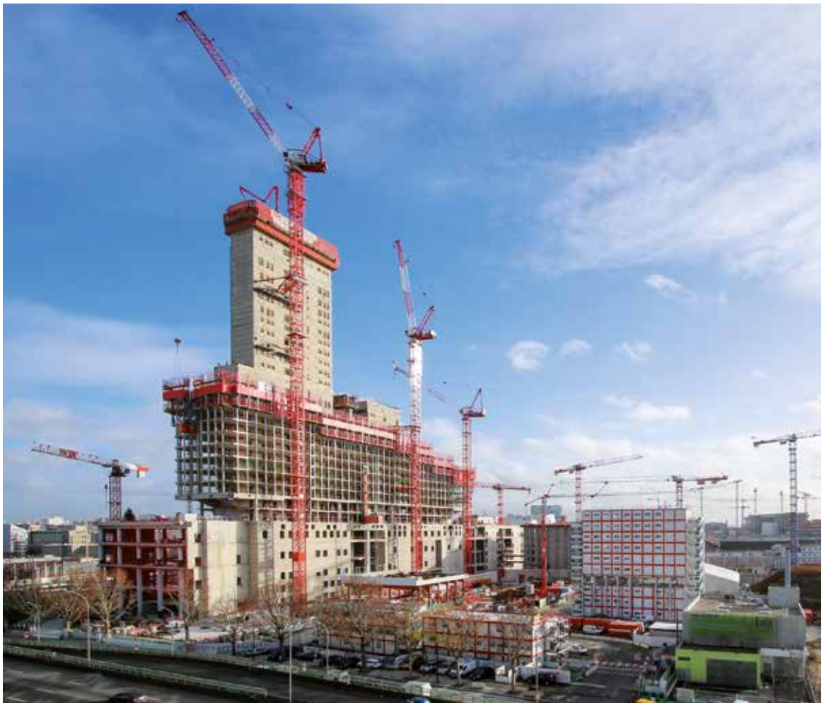
📷 Строительство Дворца правосудия в Париже, спроектированного архитектором Ренцо Пиано
