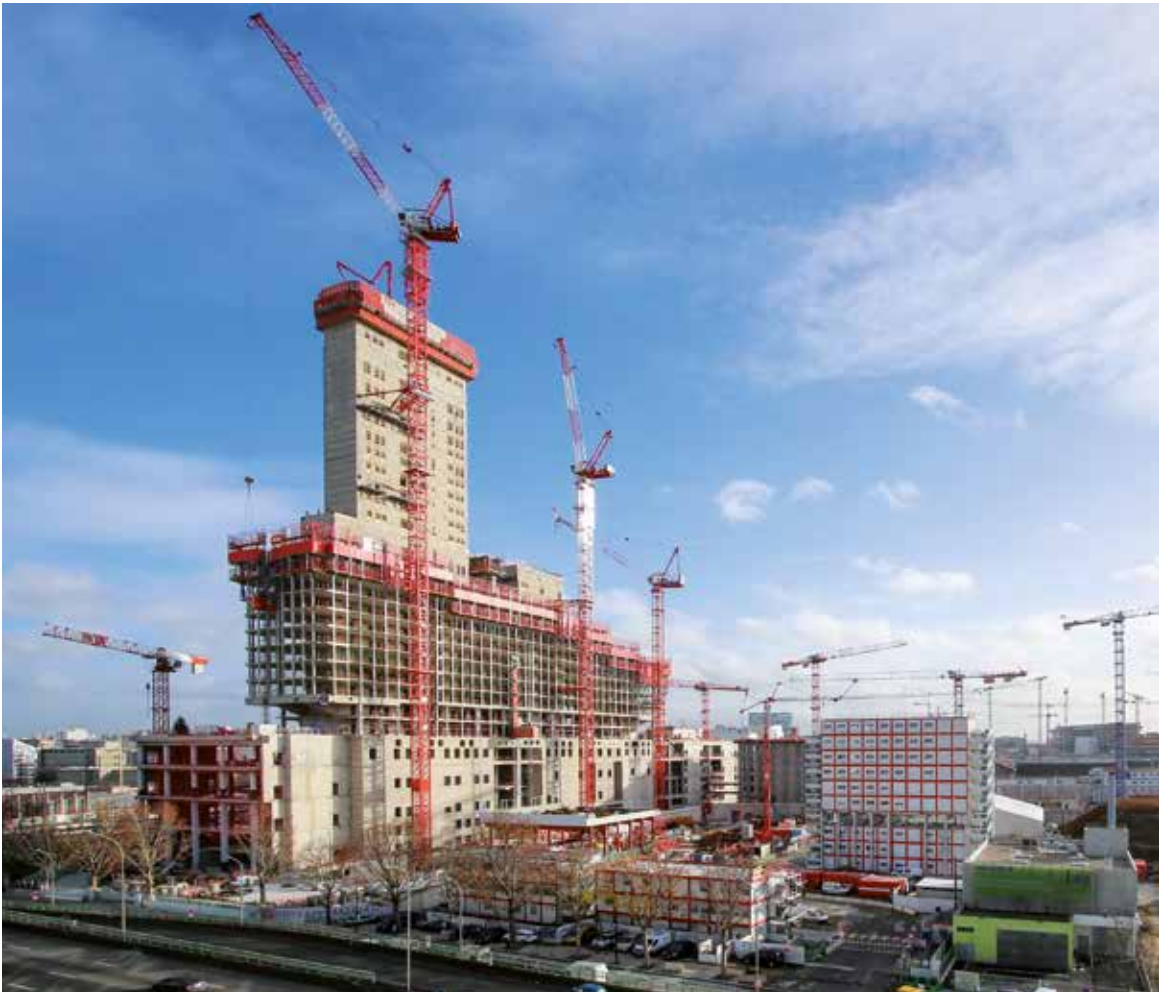
Der vom Architekten Renzo Piano entworfene und im Bau befindliche Pariser Justizpalast
