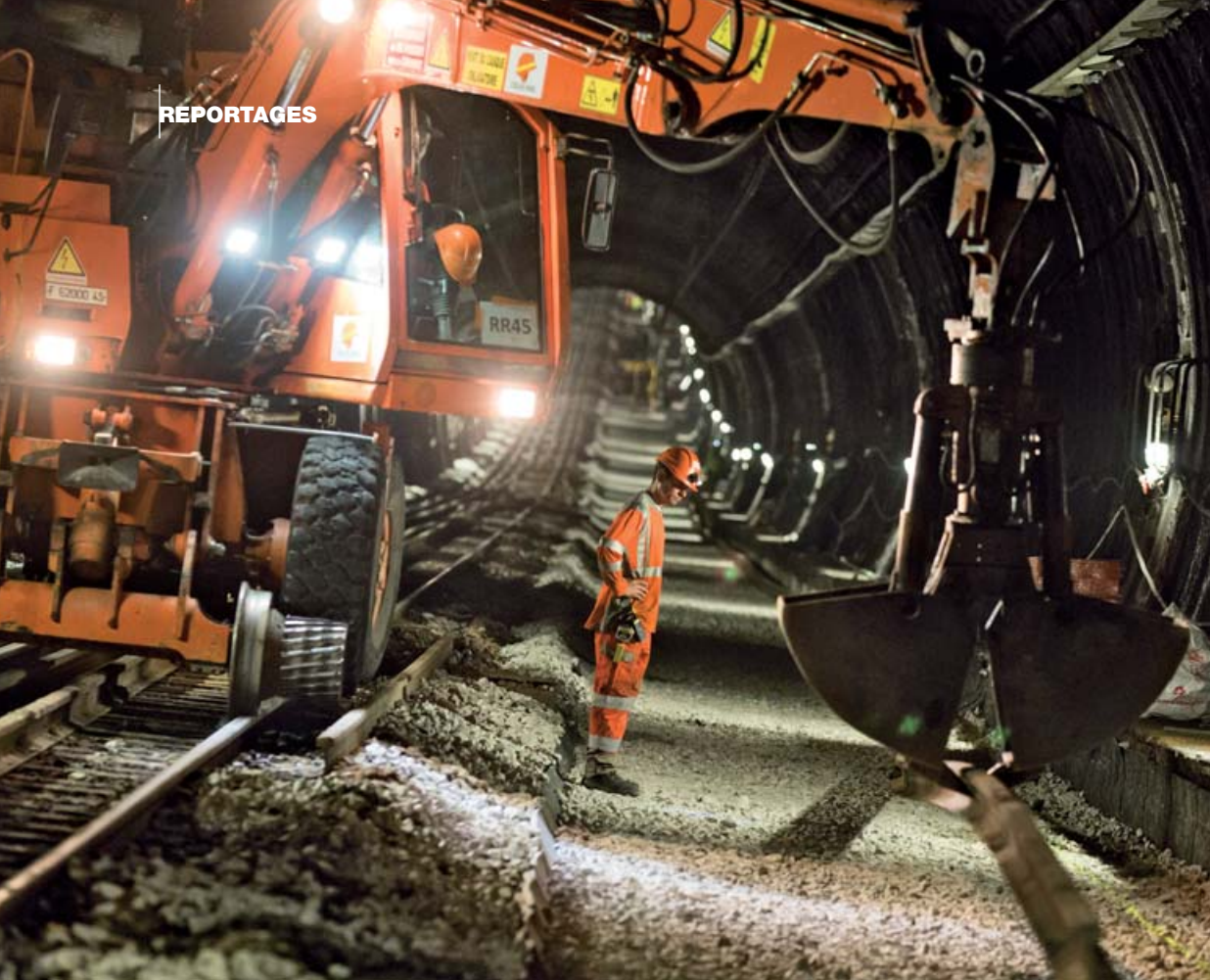
Colas Rail a renouvelé 300 mètres de voie par jour. Au centre : les collaborateurs de Colas Rail et de la RATP travaillent main dans la main sur le chantier.
