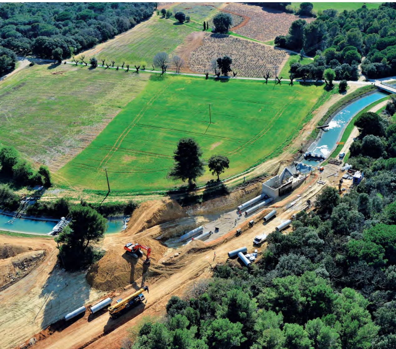
На стройке обьездной железной дороги Ним-Монпелье (Bouygues Construction – Colas - Alstom)
