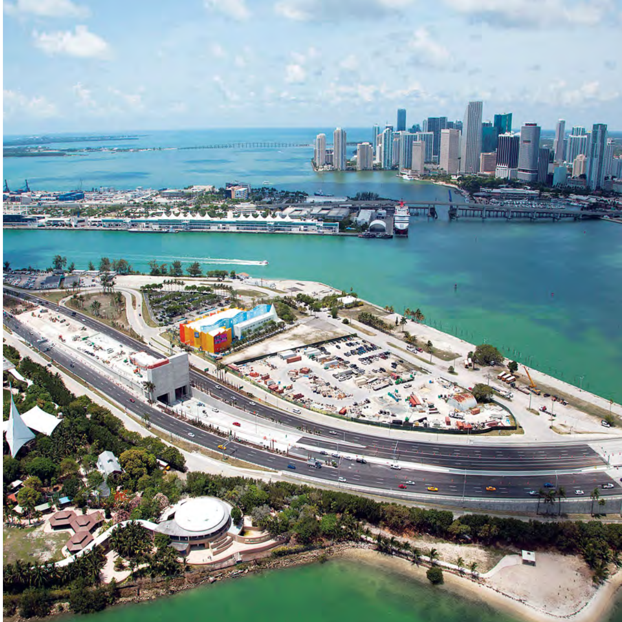
マイアミのシティセンターに通じる水底トンネル（ブイグ・コンストラクションが引渡完了）
