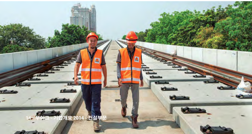
콜라스 레일, 말레이시아 수도의 경전철 1 개 노선의 연장 공사를 실시
