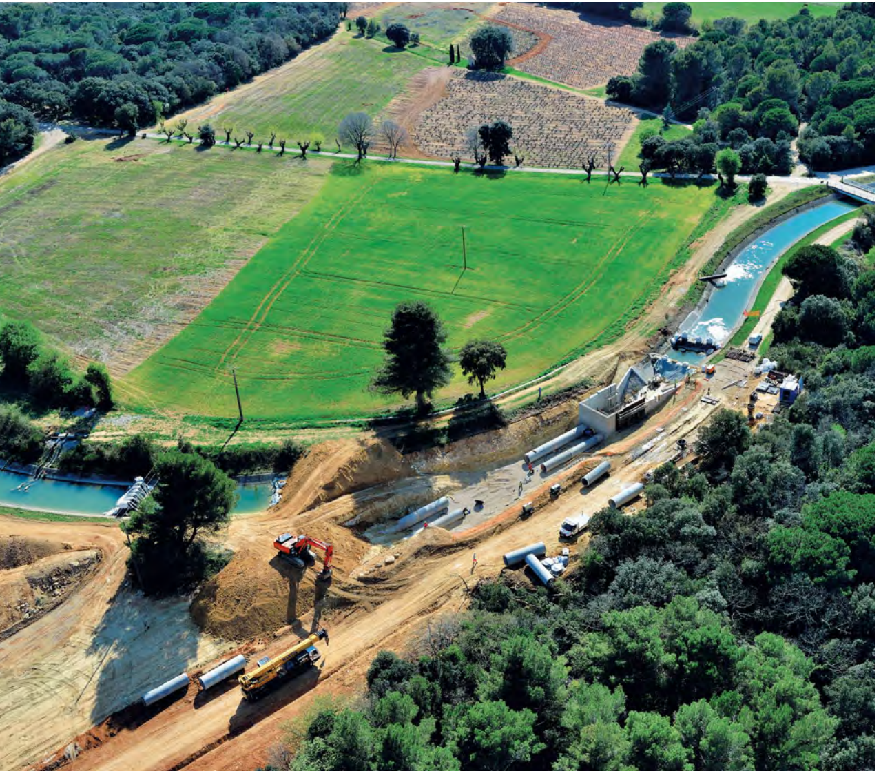
남-몽펠리에 철도 노선 우회선로 공사현장(부이그 건설 - 콜라스 - 알스톰)
