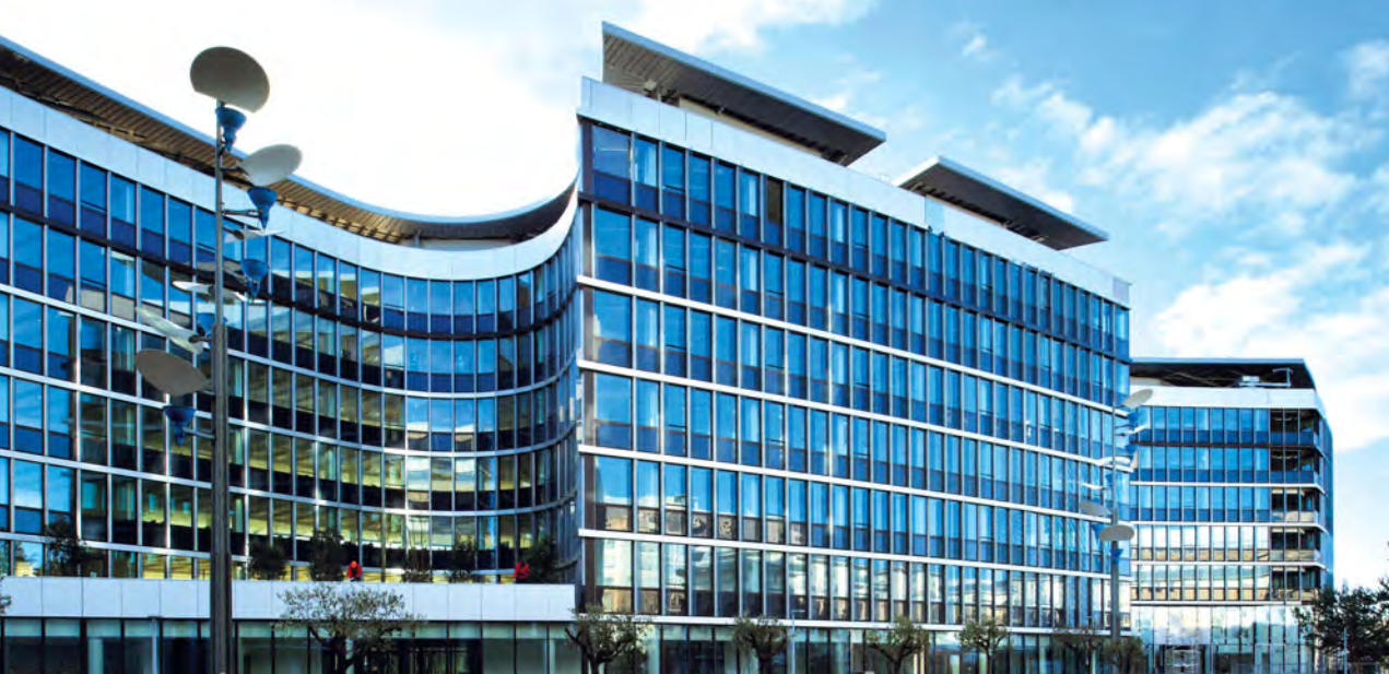
루에이(오-드-센느 지방) Green Office*, 2012년 열효율 법규 규정 대비 104 %의 에너지 절감 달성
