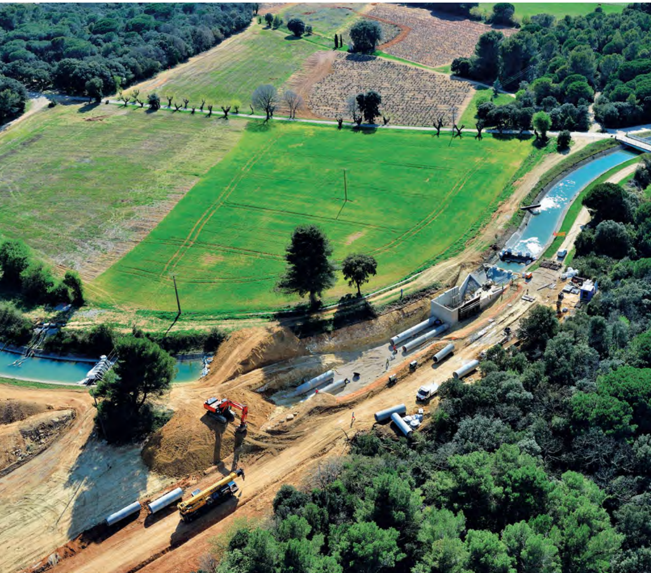
法国尼姆到蒙佩里埃高速铁路绕行工程（布依格建筑- Colas 道路建设-阿尔斯通公司）。
