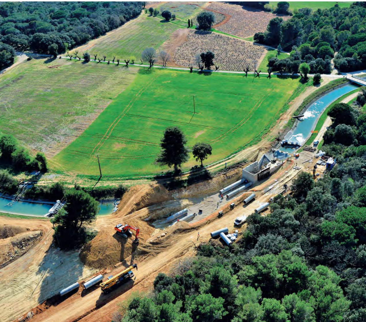
Auf der Baustelle der Bahnumgehungsstrecke von Nîmes und Montpellier (Bouygues Construction - Colas - Alstom)
