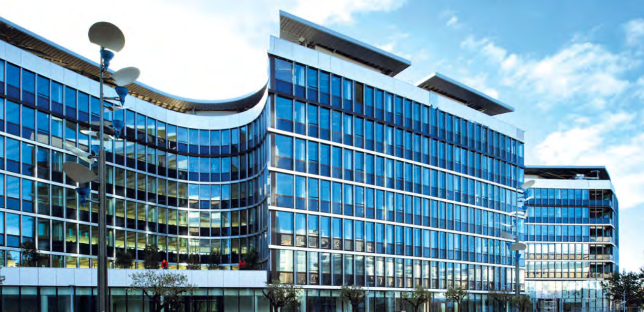
Das Green Office® Rueil im Großraum Paris erreicht gegenüber der französischen Wärmeschutzverordnung RT 2012 Energieeinsparungen in Höhe von 104 %.
