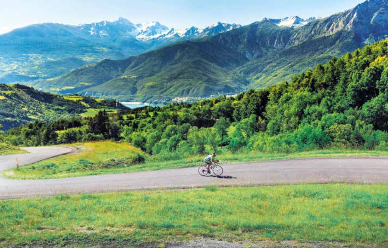
100% de áridos para mezclas bituminosas reciclados por Colas en un tramo de carretera entre Embrun y Chorges (Francia)
