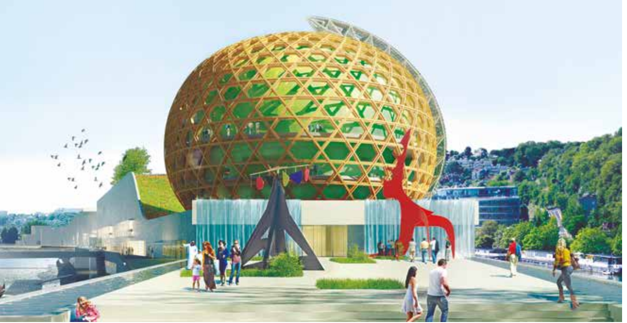
Paneles fotovoltaicos giratorios sobre la gran vela de la futura Ciudad de la Música de la isla Seguin (Bouygues Construction)
