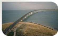
The Ile de Ré Bridge
