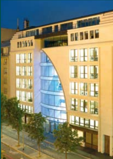
32 Ноше, штаб-квартира компании Bouygues
