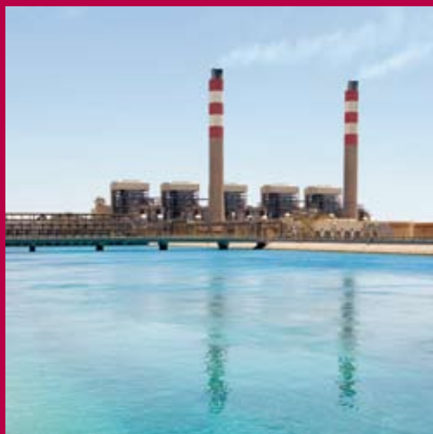
Elektrownia Shoaiba (Arabia Saudyjska)
