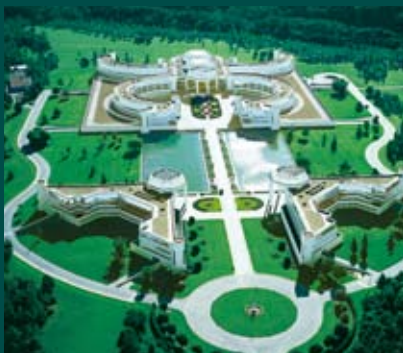
チャレンジャー ブイグ・コンストラクション本社
