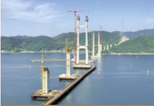
韓国馬山(マサン)湾の橋梁建設
