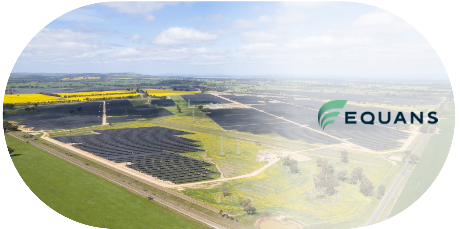
Ferme solaire de Goorambat en Australie - Equans
