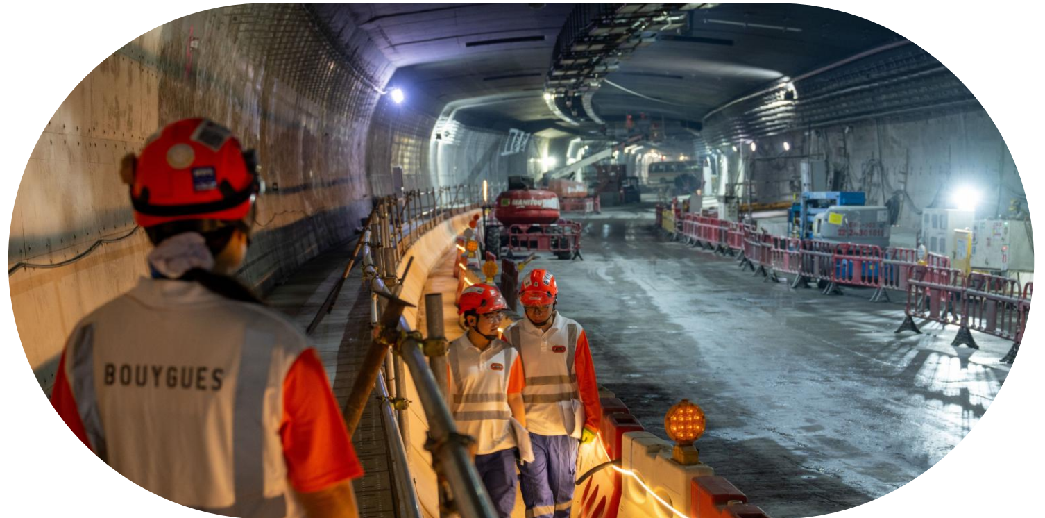
Tunnel routier Trunk Road T2 à Hong-Kong – Bouygues Construction
