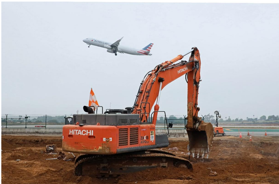
Extension du Taxiway Delta de l'aéroport international de Los Angeles (2023) – © Colas
