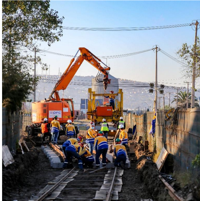
Travaux sur les lignes 3 et 6 du métro de Santiago du Chili, ©Colas
