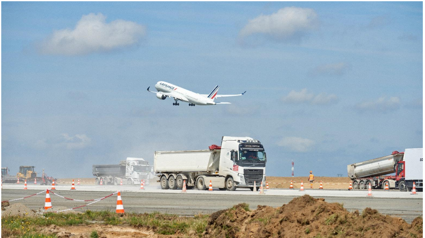
Réhabilitation de la piste 1 de l'aéroport de Paris-Charles de Gaulle en 2025, ©Colas
