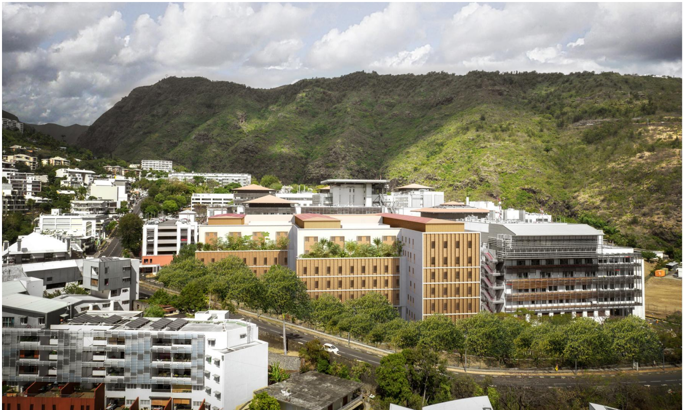
Centre hospitalier universitaire de La Réunion – Construction du Bâtiment Femme Parent Enfant ©BFPE
