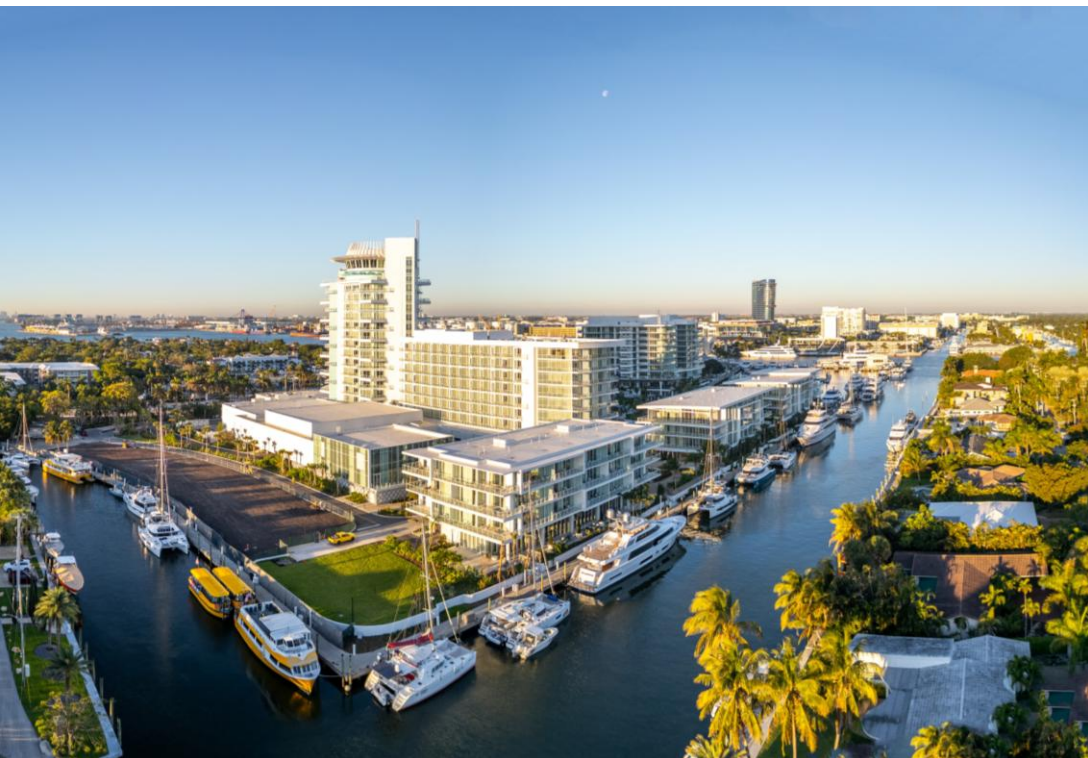
Rénovation de la tour Pier Sixty-Six à Fort Lauderdale en Floride, par Bouygues Construction
