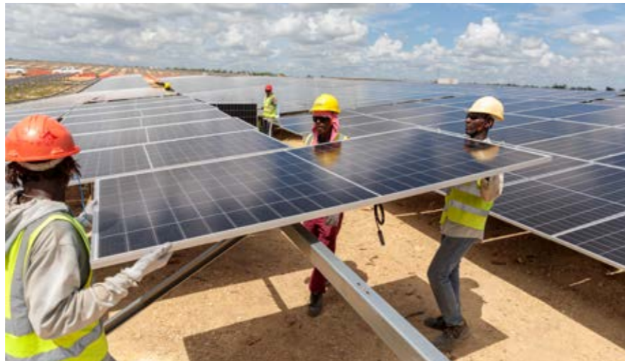
RÉPUBLIQUE DOMINICAINE - Equans Solar & Storage réalise la construction de plusieurs fermes solaires sur l'île.
