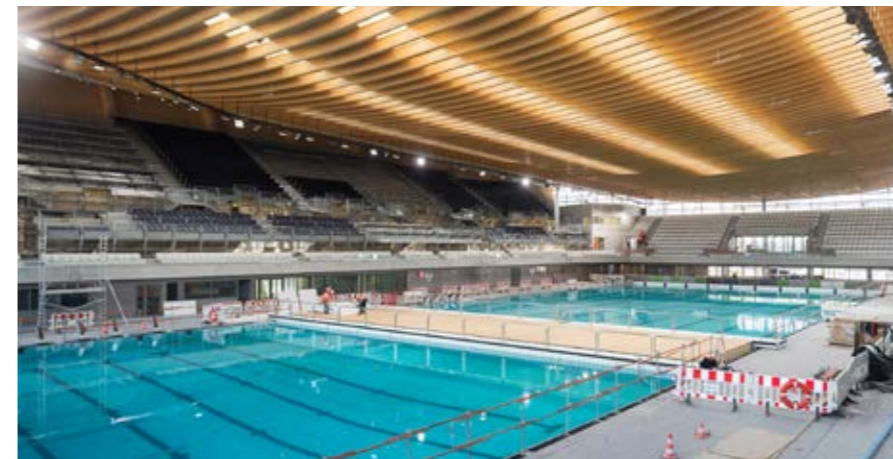
FRANCE - Le centre aquatique de Saint-Denis, réalisé par Bouygues Bâtiment Ile-de-France, possède une charpente bois concave composée de 90 catènes incurvées, chacune mesurant 55 cm d'épaisseur et atteignant une portée de 90 mètres. Un record pour la construction Bois.
