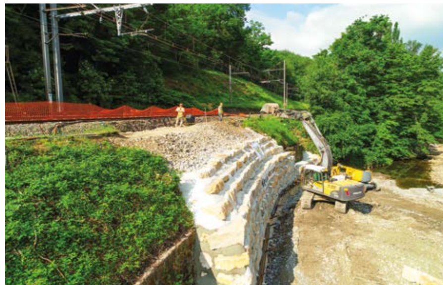
FRANCE - Aménagements hydrauliques et écologiques : berge en pente très douce en amont, zone d'expansion des crues et d'espaces naturels pour ne pas impacter la présence des castors en aval, confluence avec la rivière du Couzon pour donner au Gier un espace de divagation élargi.
