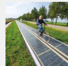
Piste cyclable photovoltaïque Wattway aux Pays-Bas par Colas
