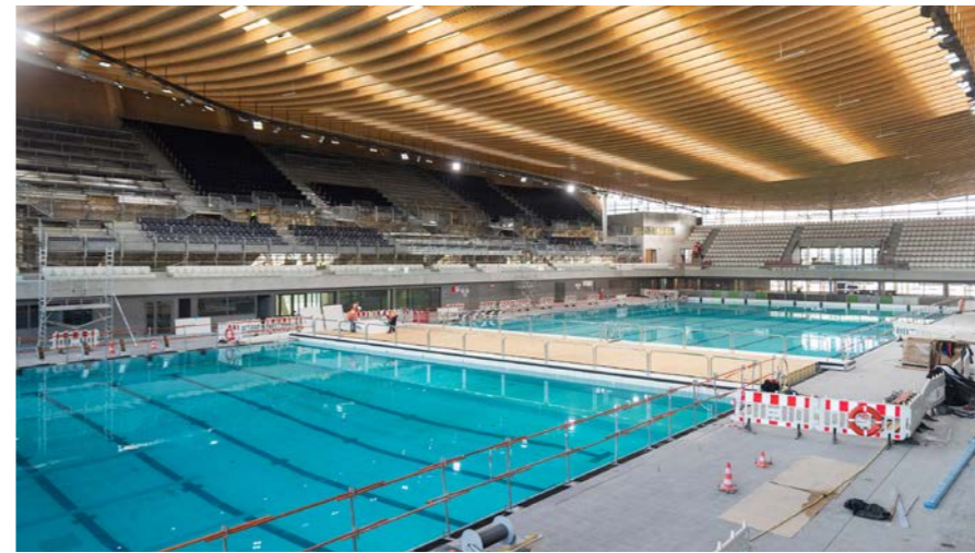
FRANCIA - El centro acuático de Saint-Denis, construido por Bouygues Bâtiment Ile-de-France, presenta una estructura cóncava de madera compuesta por 90 vigas curvas de 55 cm de espesor cada una y 90 metros de luz. Un récord para la construcción en madera.
