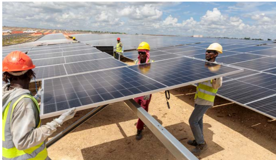
REPÚBLICA DOMINICANA - Equans Solar & Storage está construyendo varios parques solares en la isla.
