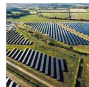
Ferme solaire au Royaume Uni, Equans Solar and Storage
