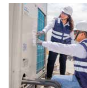
Data center Equans au Pérou
