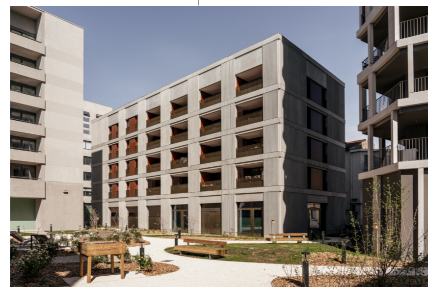
FRANCE - Au cœur du quartier Lyon Confluence, Sollys est un projet mixte qui comprend à la fois des bureaux, des logements et des commerces.
