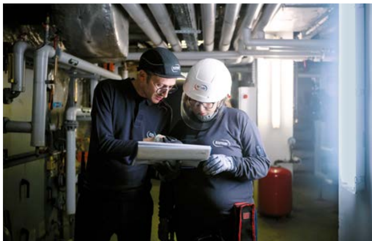
FRANCE – Electra est la première formation composée entièrement de femmes en reconversion au métier d'électricienne, initiée par Bouygues Energies & Services. Ici, Morgane Prime, aux côtés de son tuteur Idir Sidhoum.
