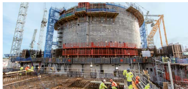
ROYAUME-UNI – Bouygues Travaux Publics, au sein du groupement Bylor, réalise le génie civil des deux réacteurs EPR de la future centrale nucléaire d'Hinkley Point.
