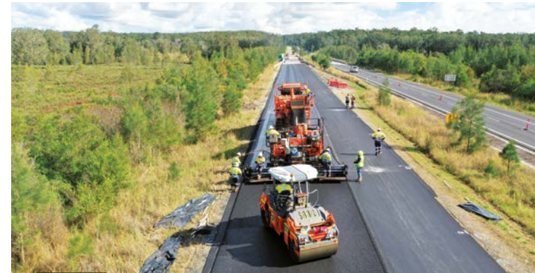
AUSTRALIË – Een team van Colas Australia brengt op een weg van Clybucca, in New South Wales een laag SMA10-asfalt aan.
