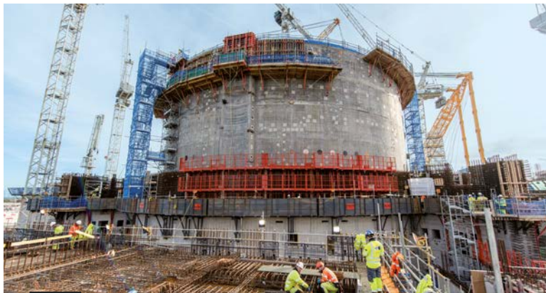
【イギリス】ブイグ・トラヴォー・ビュブリックが共同企業体Baylorの一員として手掛けている欧州加圧水型炉2基の土木工事（ヒンクリー・ポイント原子力発電所）
