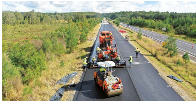
【オーストラリア】ニューサウスウェールズ州クライバッカルートにSMA10級のアスファルトを敷設するコラス・オーストラリア (Colas Australia) の作業員たち
