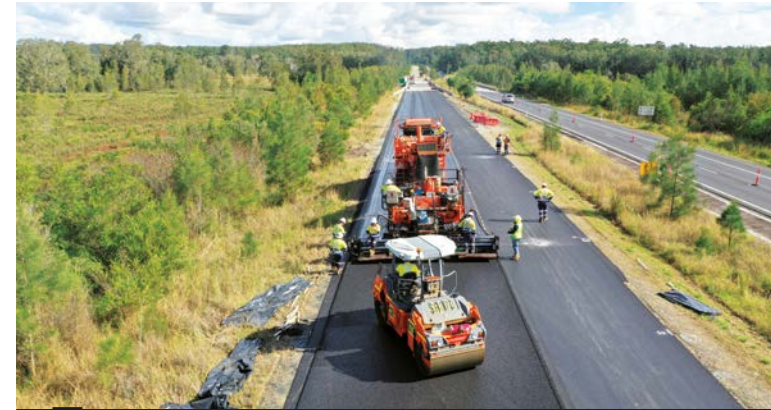
호주 - 콜라스 호주팀이 호주 뉴사우스웨일스 클라이브카의 도로에 SMA10급 아스팔트를 설치하고 있다.
